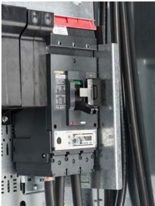
Powerpact L-Frame 250 A Main
